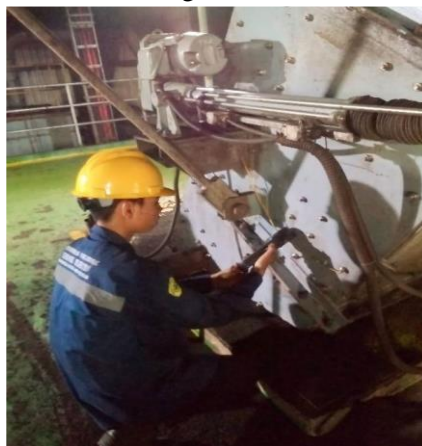
Gambar 4. Melakukan inspeksi sistem pentahanan pada motor diverter gate menggunakan megger
