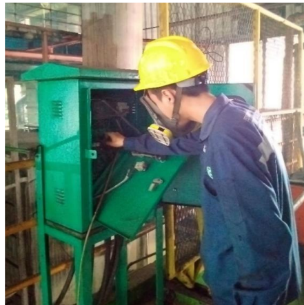
Gambar 10. Melakukan check and tightening pada panel control local
