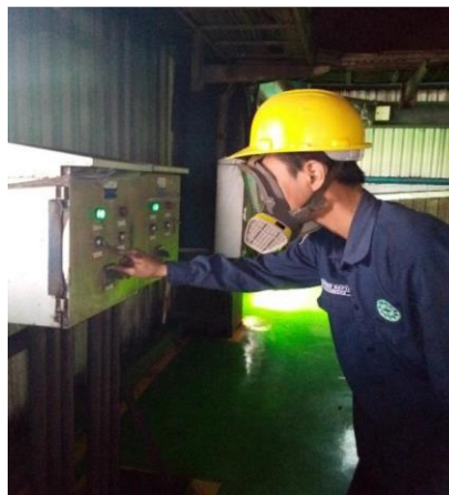
Gambar 11. Melakukan inspeksi lampu indikasi dan switch pada panel control local
