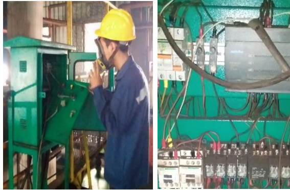
Gambar 3. Saat inspeksi kelengkapan instalasi dan terminasi
