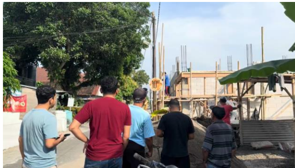
Gambar 3. Survei lokasi pemasangan CCTV.
