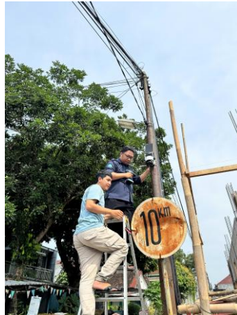
Gambar 6. Proses Instalasi CCTV Pada Titik Tiang Yang Sudah Ditentukan.
