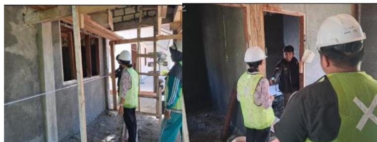
Gambar 4. Monitoring Pembangunan 50% di SD di Bonggo – Kabupaten Sarmi.
