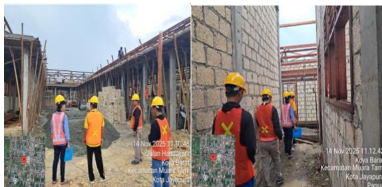
Gambar 3. Monitoring Pembangunan 50% di SD di Koya Barat – Kota Jayapura.
