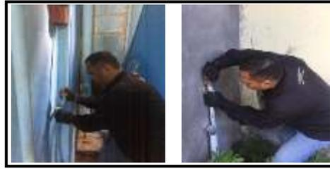
Gambar 4. Instalasi pemipaan air bersih dari pompa induk menuju wastafel
