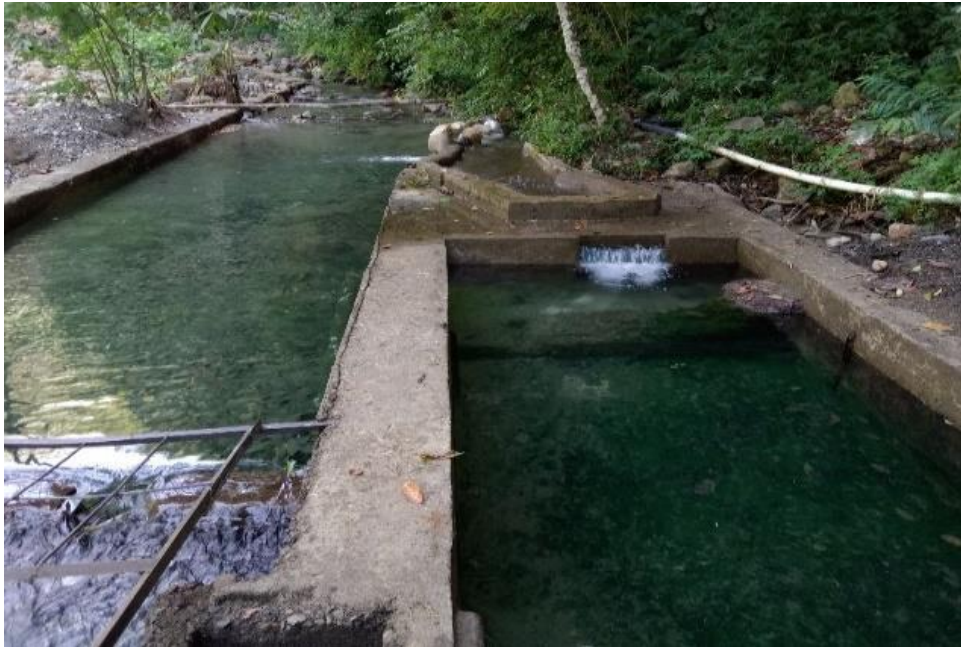
Gambar 2. Bangunan pengambilan air Waena di Sungai Kampwolker. Sumber: Hasil observasi lapangan (2022).
