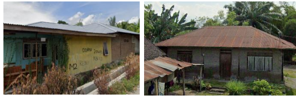
Gambar 3. Dokumentasi Rumah (Rangka Kayu Dengan Dinding Tembokan), Kabupaten Sigi.
