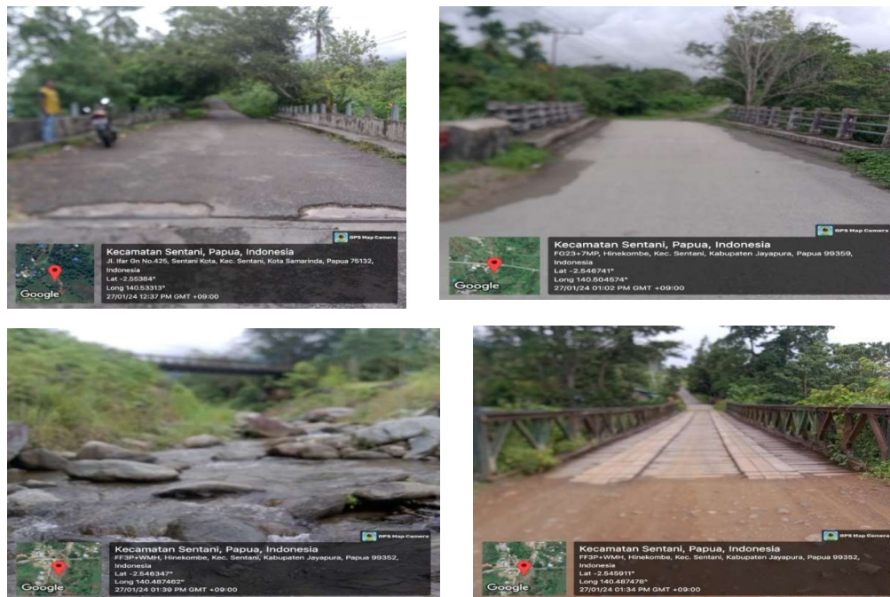
Kondisi Jembatan Di Areal Lokasi Penelitian Sumber : Survey Tahun 202
