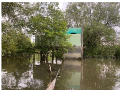
Gambar 4. Rusaknya fasilitas umum
