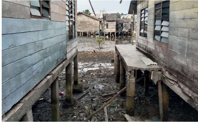
Gambar.6 Kondisi Pemukiman Kosgoro, Memprihatinkan
