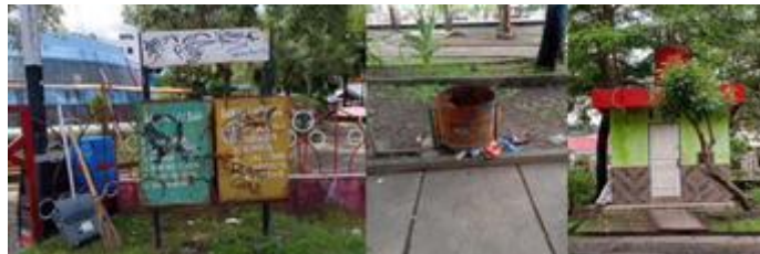
Gambar 5. Kondisi Fasilitas Kebersihan (Tempat Sampah dan Toilet)
