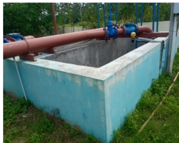
Gambar 2. Intake (Sumber : Dokumentasi Pribadi)
