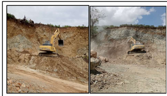
Gambar 1 Kondisi front kerja
