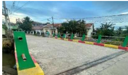
Gambar 3 Existing Jembatan. Sumber: Data Survey, 2025.
